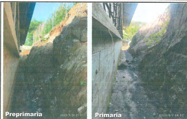
Foto 1: Imagen en donde se desea realizar el mejoramiento del muro de contención en área de preprimaria y primaria debido a peligro por deslave
